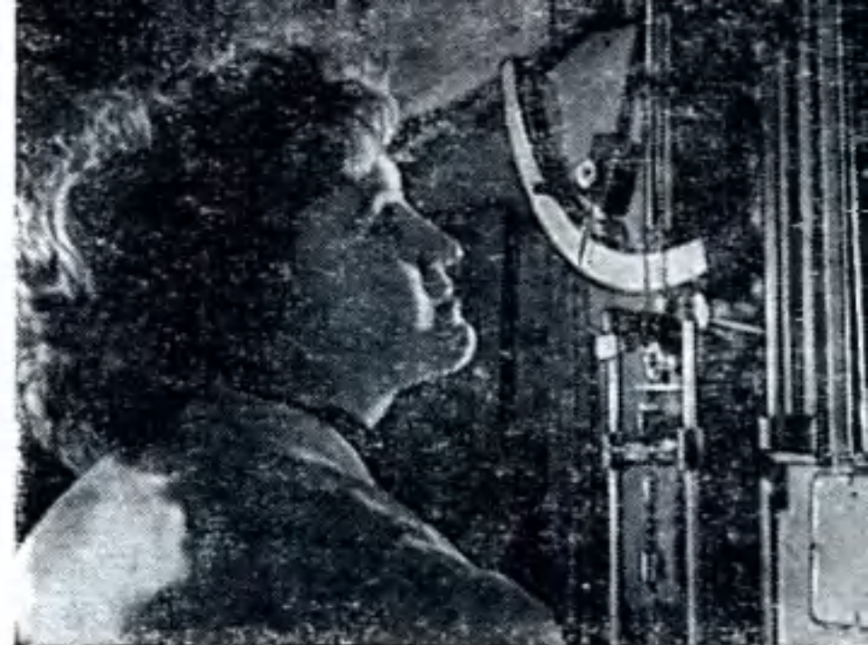
Лаборантка Научно-исследовательского института шинной промышленности З. Н. Марушина испытывает образец резины на каучуке СКИ.
